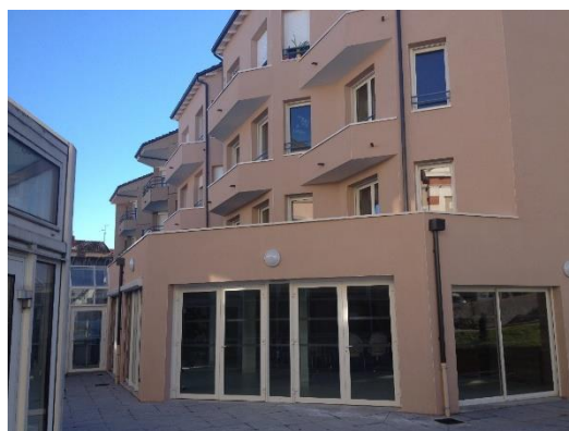
La salle polyvalente au rez de chaussée du bâtiment hébergement
